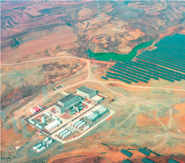
日照200MW光伏配储项目
