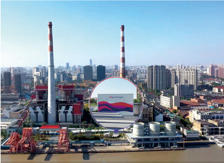
上海杨浦滨江灰仓“零碳智慧综合能源中心”示范项目
